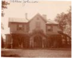
363 Old Post Road (FF_BLDGS_363Old Post Rd1)
