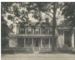
480 Old Post Road (FF_BLDGS_480Old Post Rd_1)
